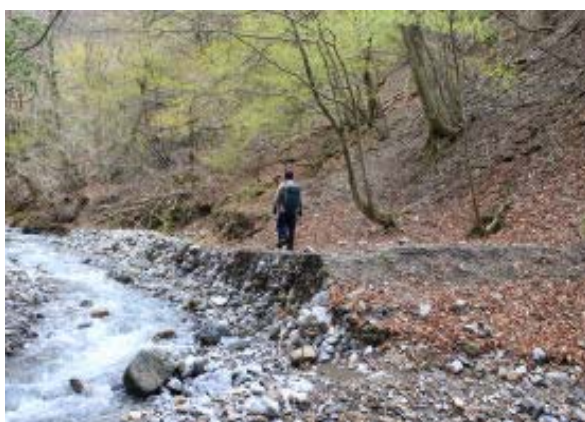
西尾根取付き地点 ② 赤テープあり
