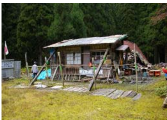
一部損壊した八丁温泉建屋
