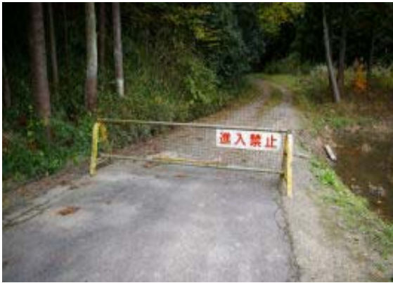
林道の車進入防止柵 ⑬
