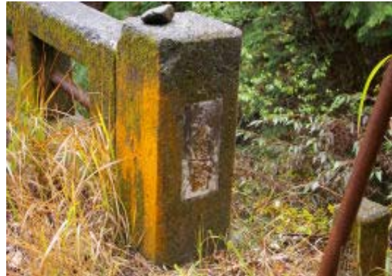
参道橋（この上部の空き地で駐車）⑤
